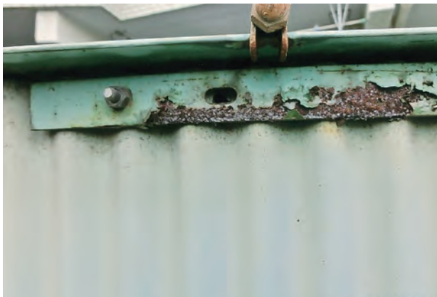
HALTを塗布しないとサビが進む
