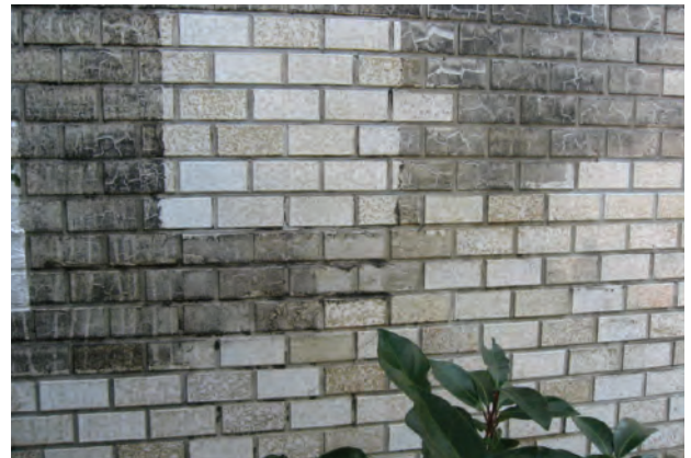
洗浄のテスト施工
