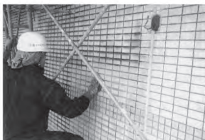
スペースショットによる洗浄作業
