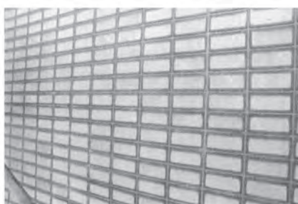
作業前の状態
