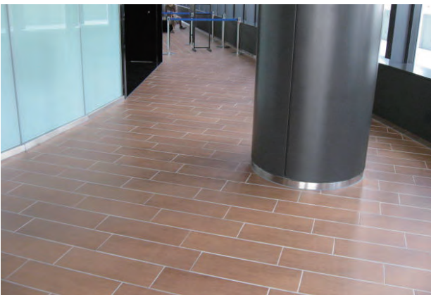
5階エレベーター出口通路目地部分
